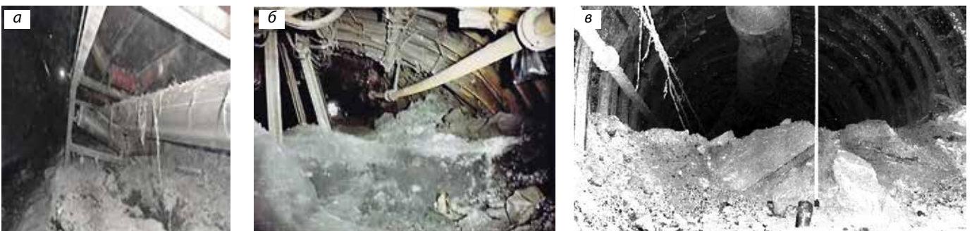
Рис. 3. Деформации выработок по середине (а) и по бокам (б) выработок и их измерение (в) Fig. 3. Deformations in the middle (a) and on the walls (b) of the workings and their measurements (v)
