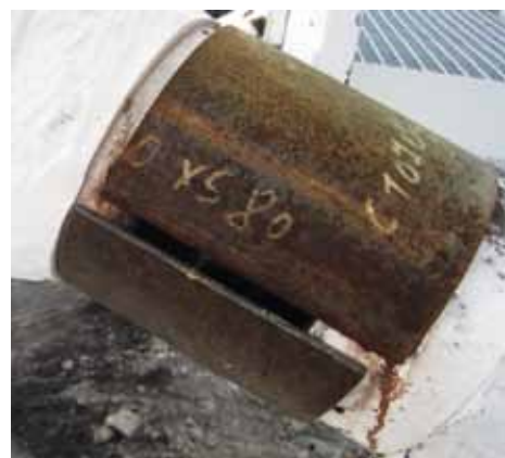
Рис. 5. Установка разрезной втулки на регулируемых раскосах стрелы Fig. 5. Installation of the split sleeve on the adjustable boom struts
