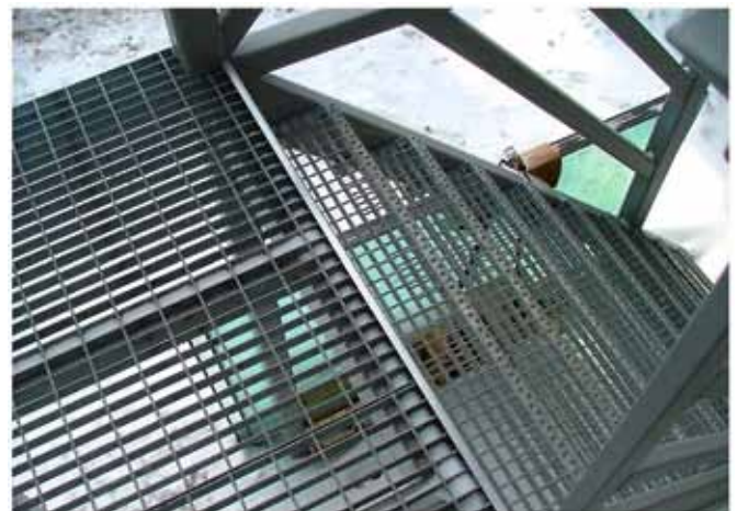
Рис. 3. Замена стандартного покрытия площадок обслуживания на пресс-настил
