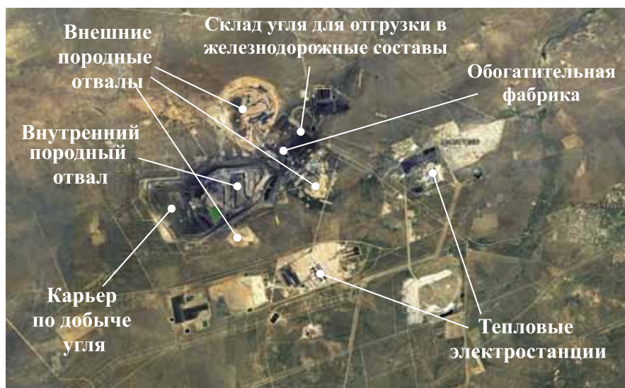
Расположение предприятий топливно-энергетического комплекса в северной части провинции Лимпопо на территории Южно-Африканской Республики (на снимке из космоса)
