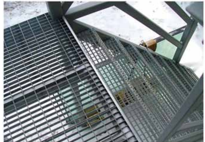
Рис. 3. Замена стандартного покрытия площадок обслуживания на пресс-настил
